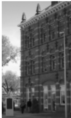
西部都市ガス工場
