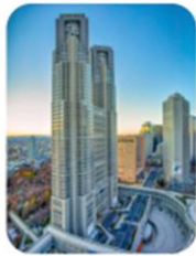
The Tokyo metropolitan government office 東京都庁
