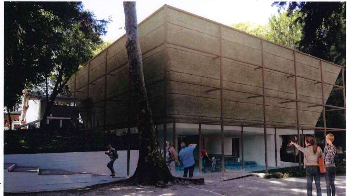
右中/外観のイメージ。建物に水を集めるための茅葺き屋根が、日本館に向けて勾配を取っている。下からは生み出された水が流れ出てくる。
