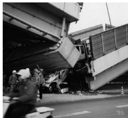
写真1 阪神高速道路神戸線の倒壊
