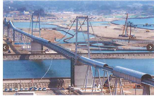
陸前高田市のかさ上げ土砂用ベルトコンベアー (朝日新聞)
