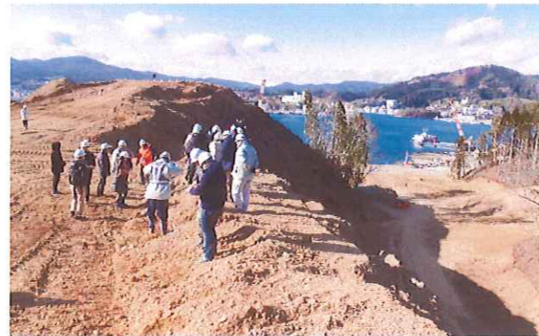
気仙沼市の高台移転工事現場
